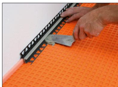
**11** Einbau des Randbewegungsfugenprofils Schlüter®-DILEX-EK bzw. -RF.
