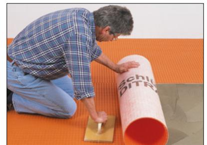
**9** Verlegung der Entkopplungsmatte Schlüter®-DITRA 25 (in Verbindung mit Keramik- und Natursteinbelägen) in frischem Dünnbettmörtel nach Begehbarkeit des Estrichs. Bei Calciumsulfatestrich nach einer Restfeuchte von  $\leq 2\%$ .
