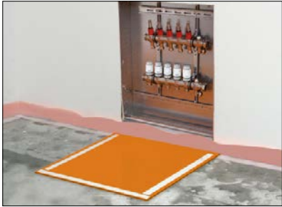
4 Verteilerbereich – beigefügte Doppelklebebänder aufbringen.
