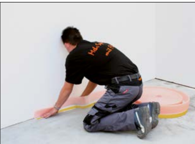
2 Einbau des Randstreifens BRS 808 KSF mit Klebestützfuß.
