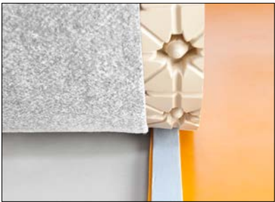
10 Türbereich / Verteilerbereich – Estrichnoppenplatten EN 18 FTS auf Ausgleichsplatte EN FG passgenau verkleben.
