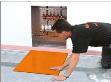
3 Verteilerbereich – Ausgleichsplatte EN FGTS (glatte Folienplatte) einpassen.
