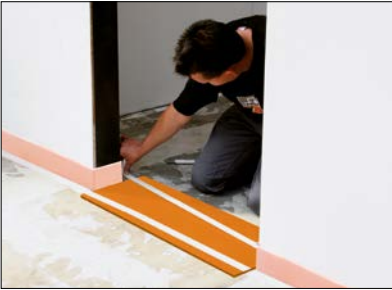
6 Türbereich – beigefügte Doppelklebebänder aufbringen.
