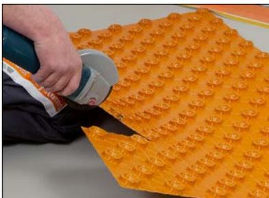
**7** Verarbeiten der Estrichnoppenplatte – Schneiden im Noppenbereich: Winkelschleifer benutzen.
