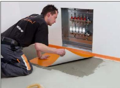
**4** Verteilerbereich – Ausgleichsplatte EN FGK (glatte Folienplatte) mit Dünnbettmörtel verkleben.
