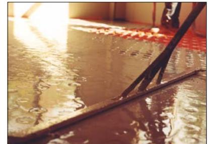
**16** Alternativ zu **14** und **15** : Einbringen eines Fließestrichs auf Estrichnoppenplatte BEKOTEC-EN 12 FK. Um eine planebene Oberfläche zu erzielen, eignet sich z. B. das Schwabbeln mit einem groben Besen oder Schwabbelstange (Estrichgüte CAF/CTF-C25-F4, max. F5).
