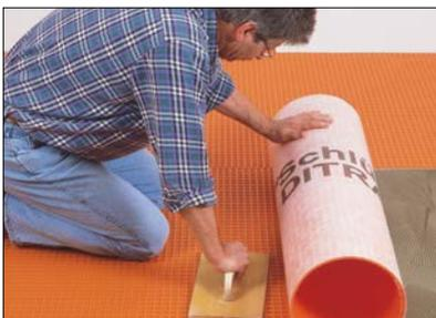
**17** Für keramische Beläge/Naturstein: Verlegung der Verbundentkopplungsmatte Schlüter-DITRA in frischem Dünnbettmörtel nach Begehbarkeit des Estrichs. Bei Calciumsulfatestrich nach einer Restfeuchte von  $\leq$  2%.
