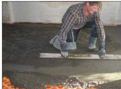
**15** Abziehen der Estrichfläche mit einer Mindestüberdeckung von 8 mm. Höhenausgleich bei bereichswiseigen Unebenheiten bis max. 15 mm Estrichüberdeckung (für nichtkeramische Beläge Datenblatt 9.5 beachten).
