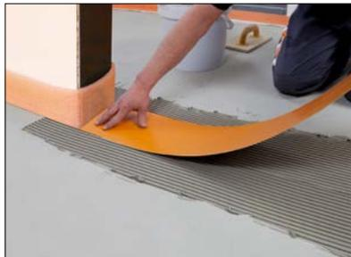
**5** Türbereich – Ausgleichsplatte EN FGK (glatte Folienplatte) einpassen und mit Dünnbettmörtel verkleben. Ggf. an der Oberseite beigefügtes Doppelklebeband aufbringen.
