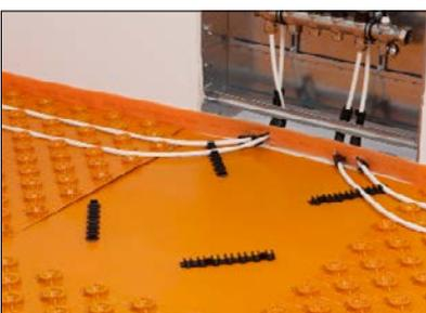
**10** Verteilerbereich – Rohrklemmleisten BTZRKL 10/12 zur Rohrführung nach Bedarf aufkleben.
