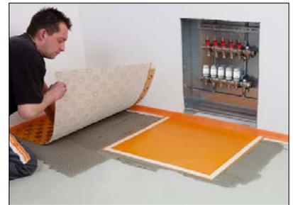
**9** Verteilerbereich – beigefügte Doppelklebebänder aufbringen und Estrichnoppenplatten EN 12 FK auf Ausgleichsplatte EN FGK verkleben.
