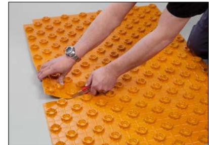
**6** Verarbeiten der Estrichnoppenplatte – Schneiden zwischen den Noppen: mit scharfem Messer/ Cutter anschneiden ... und brechen.
