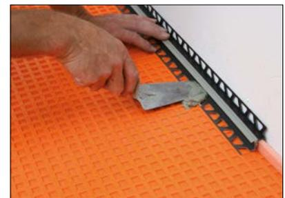
**19** Einbau des Randbewegungsfugenprofils Schlüter-DILEX-EK bzw. -DILEX-RF.
